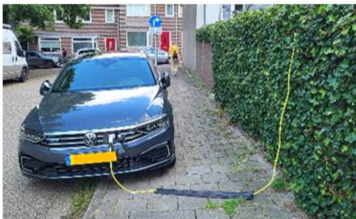
Kabel onder een kabelbrug
