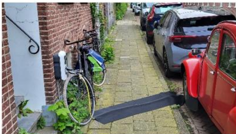
Kabel onder een kabelmat
